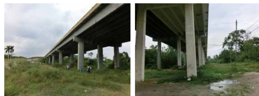
7 Puente sobre el Río Puerto Escondido (185m)
